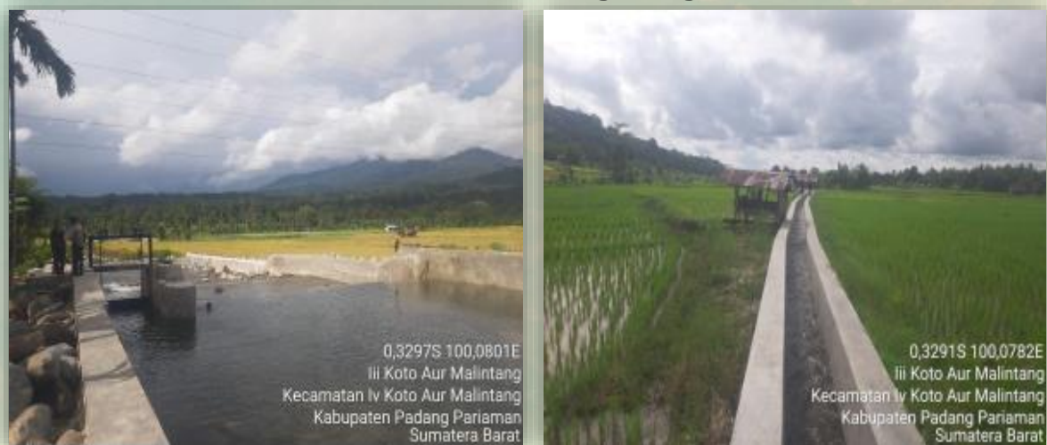
Gambar 3.11 Rehabilitasi Jaringan Irigasi
