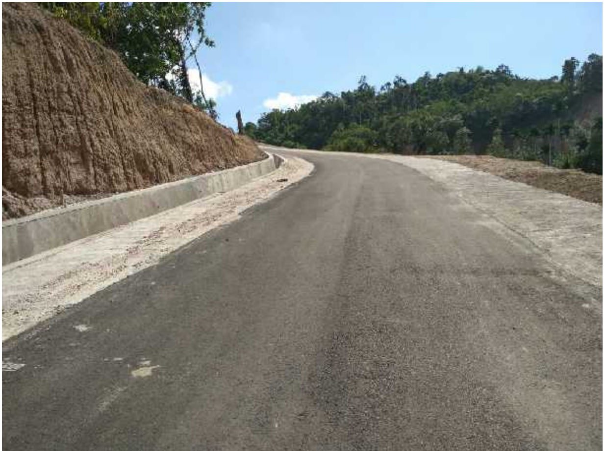
Peningkatan Struktur jalan koto Mambang – sei. Asam
