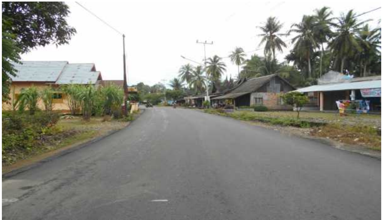
Peningkatan kapasitas Struktur jalan pauhkambar – paritmalintang
