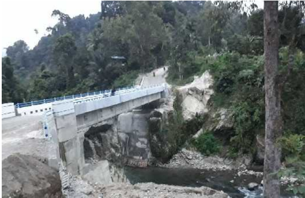
Pembangunan Jembatan Guguak Kec. 2 X 11 Kayutanam
